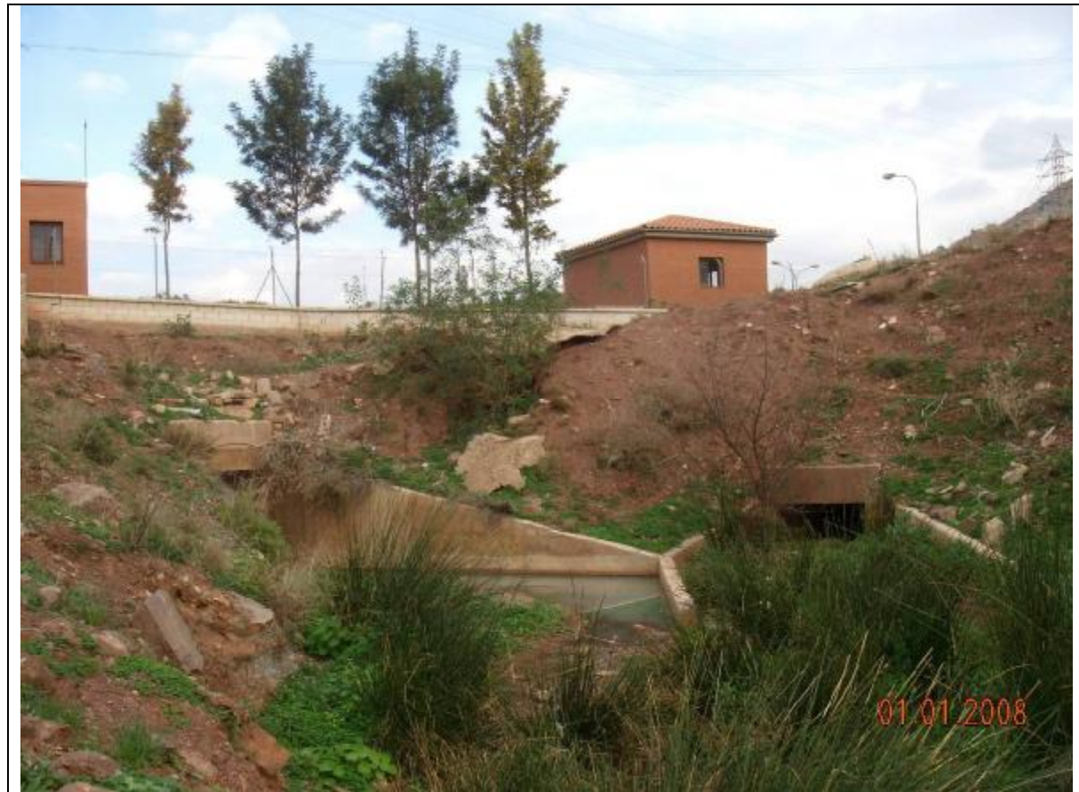
Fotografía 6 – Desde aguas abajo contemplamos las dos boquillas, con la EDAR al fondo
