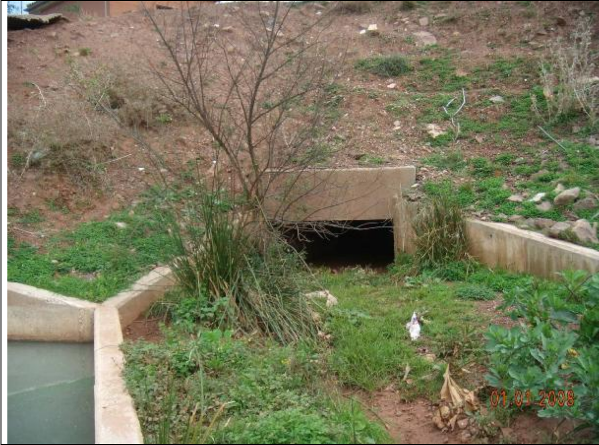
Fotografía 5 – La boquilla oriental presenta una salida libre de 2,00 x 1,00 m. Existe un claro aterramiento por lo que no sabemos cual es su altura libre total.
