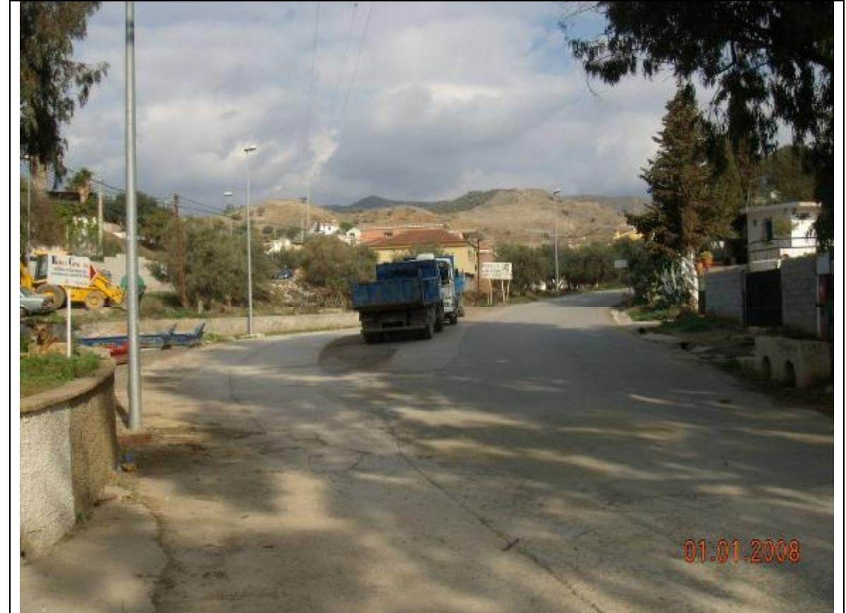
Fotografía 27 – El cauce se deriva hacia la izquierda de la carretera y la cruza sin la existencia de ninguna obra de drenaje.
