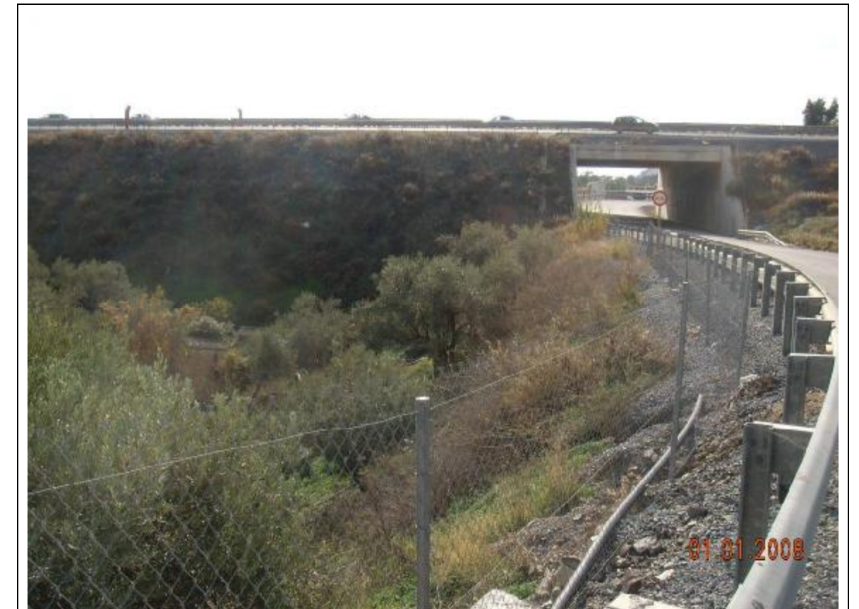
Fotografía 32 – Al norte de la autovía situados en la carretera de Olías. Vemos la vaguada que conforma el arroyo.
