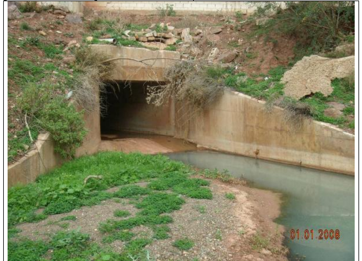
Fotografía 4 – Al sur de la EDAR existen dos boquillas de salida de las obras de drenaje longitudinal que la atraviesan. Esta es la más occidental; tiene una dimensión de 3,00 x 2,00 m.
