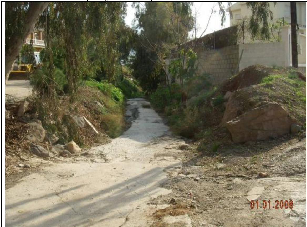
Fotografía 26 – Nos hemos desplazado hasta la barriada de Jarazmín para seguir el cauce principal de esta cuenca. Desde la carretera de Olías que mostramos en la fotografía posterior, desciende hacia la posición que hemos mostrado en la fotografía nº 17.
