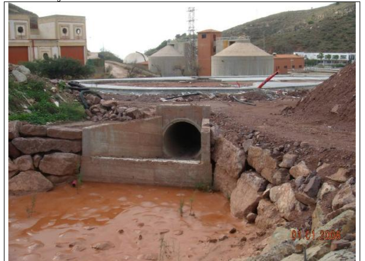
Fotografía 20 – El origen del cauce oriental que cruza la EDAR se conforma con dos subcuencas. Esta tubería de 1,80 m de diámetro capta la más occidental.
