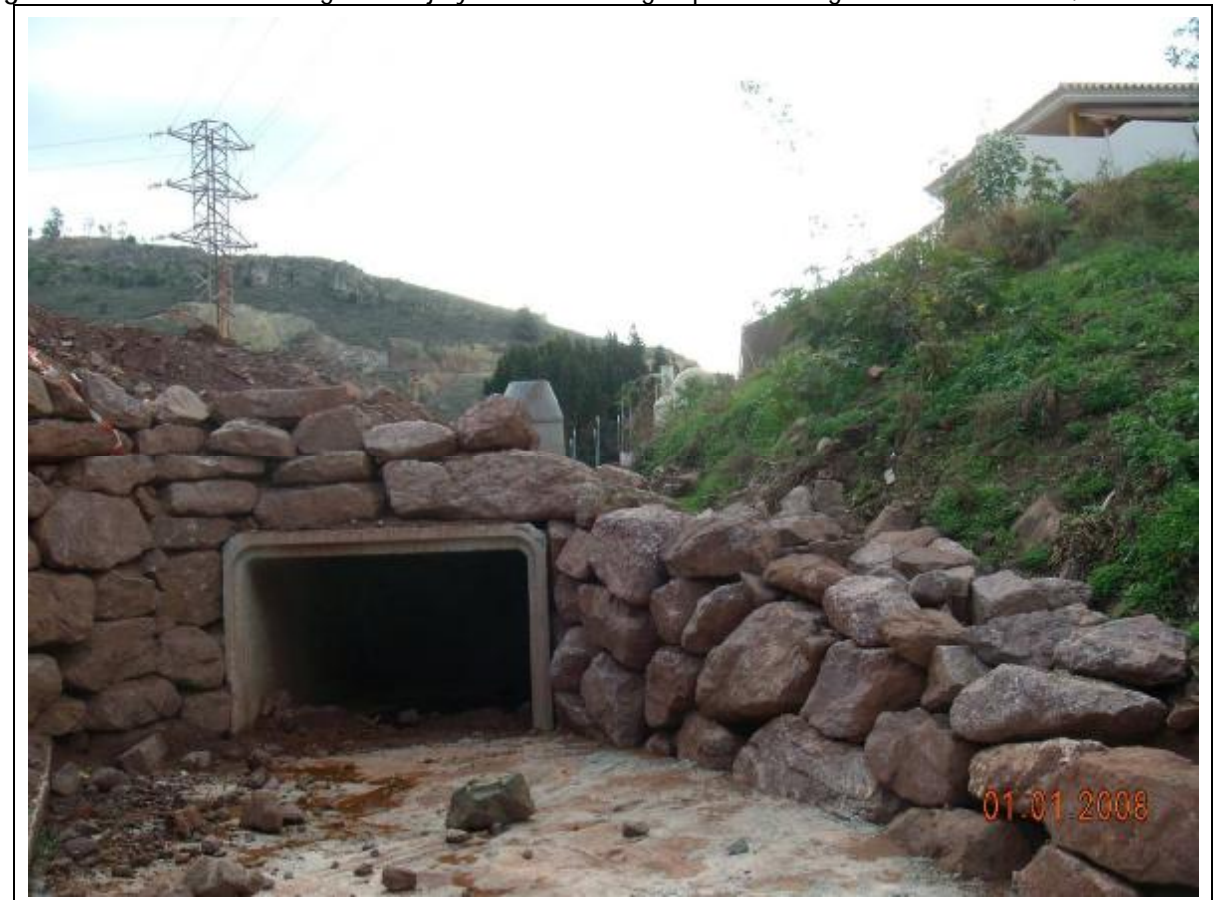
Fotografía 8 – Esta es la embocadura, al norte de la EDAR, del cauce principal del Jarazmín. Su dimensión es de 3,00 x 2,00 m. Igual que en la salida.
