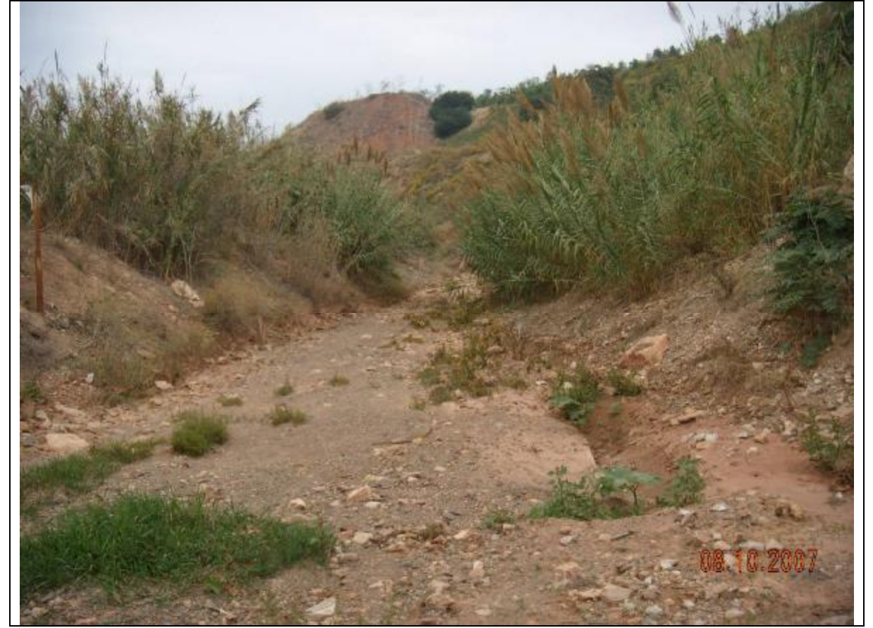
Fotografía 3 – Mirando hacia aguas arriba, desde la misma posición, vemos un cauce bien definido
