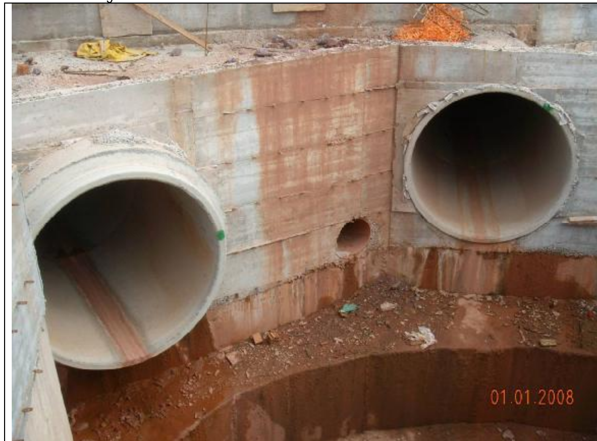
Fotografía 22 – El arquetón visto desde aguas abajo. Con los dos tubos comentados.
