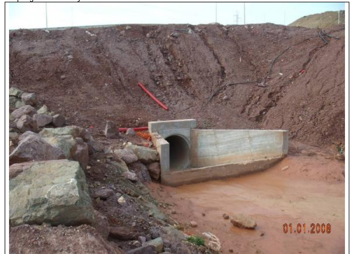
Fotografía 24 – Esta es la embocadura del arroyo intermedio que llega a la EDAR. Se junta con el cauce anterior en el arquetón que hemos mostrado.
