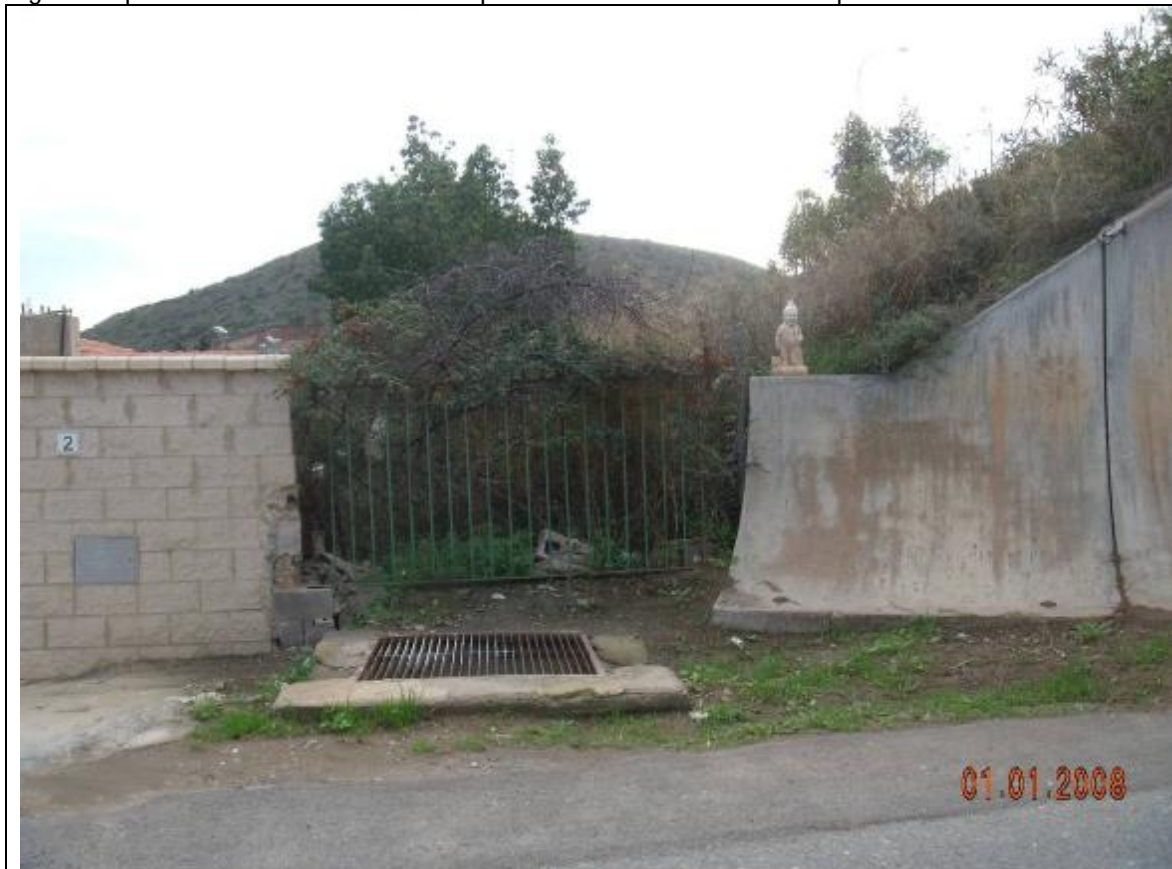
Fotografía 14 – Vemos la misma arqueta tomada con detalle en la fotografía anterior. La escorrentía que llega a esta zona es captada por la arqueta y transportada hacia el Jarazmín con esta tubería.
