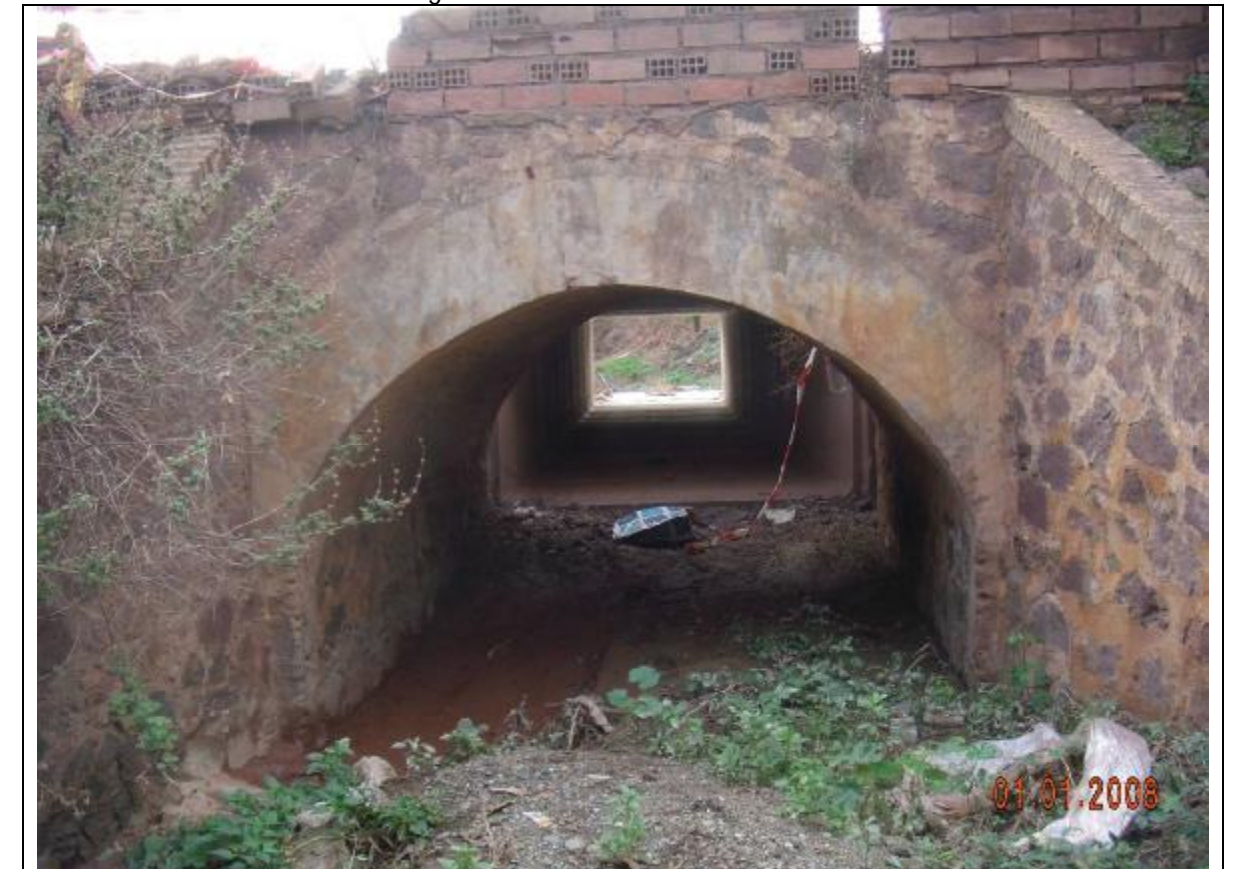
Fotografía 16 – Nos hemos desplazado de nuevo hasta el cauce principal de la cuenca. Vemos una obra de paso antigua con un gálibo lateral de 3,00 m y un nuevo cajón de 3,00 x 2,00m.
