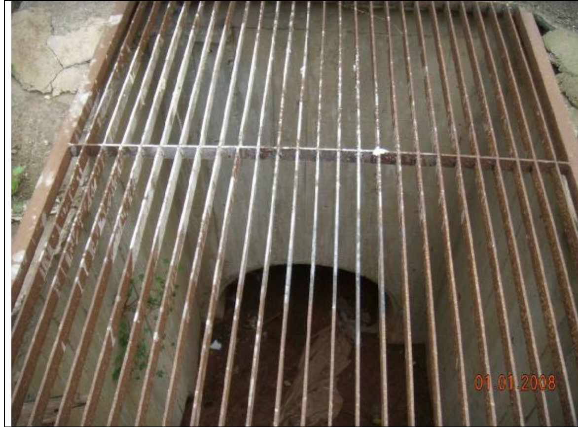
Fotografía 13 – Teníamos duda de si una zona situada al noreste de la autovía vertía en el Jarazmín. Con las tres fotografías que hemos tomado en este emplazamiento nuestra duda ha quedado resuelta.
