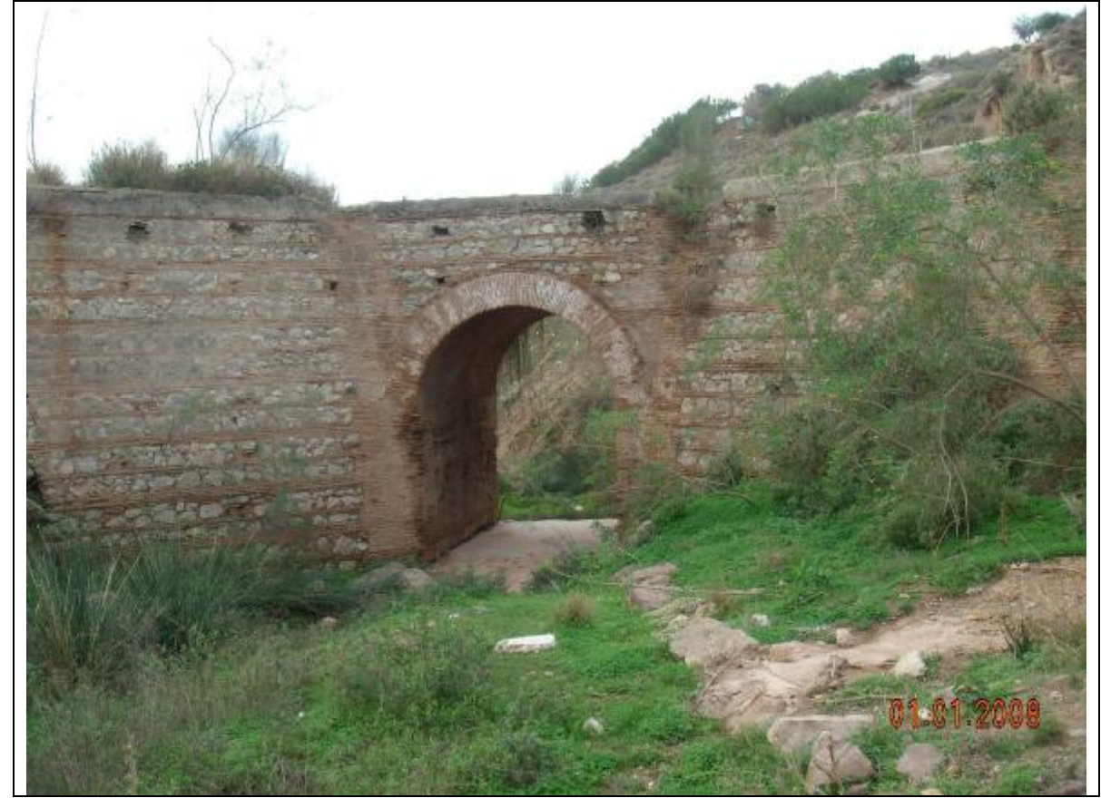
Fotografía 7 – Miramos hacia aguas abajo y vemos un antiguo pontón. Su gálibo lateral es de 4,00 m.
