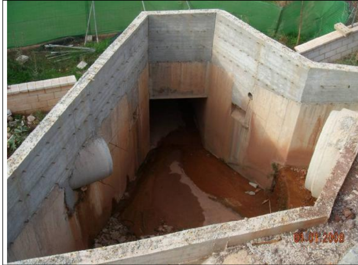
Fotografía 21 – Mostramos el arquetón que une las dos tuberías. Bajo nuestros pies está el tubo mostrado en la fotografía anterior. De frente vemos el cajón que pasa por debajo de la EDAR. con más calado que la salida que mostrábamos en la fotografía nº 5.
