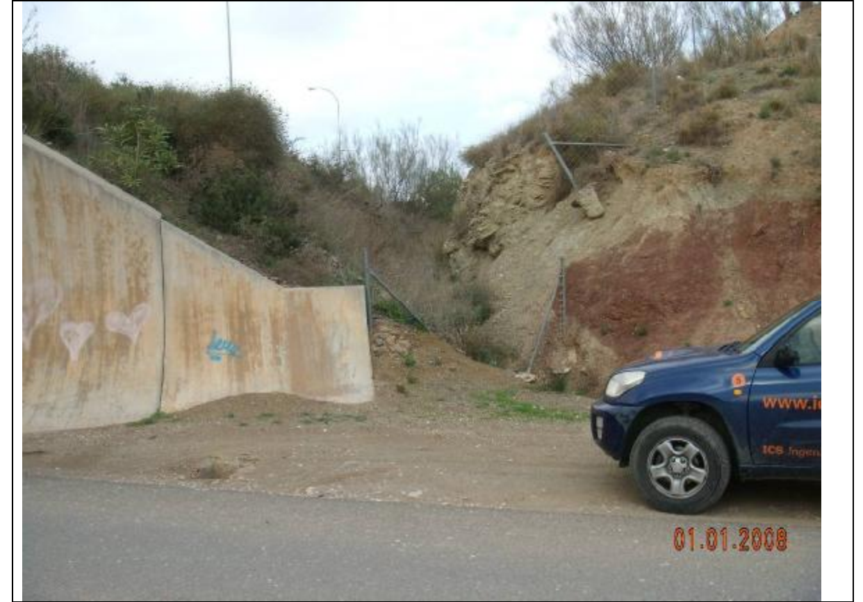
Fotografía 15 – Nos muestra esta fotografía, tomada girando la cámara respecto de la anterior 180 ° como llega hasta esta zona la escorrentía de la margen noreste de la autovía.
