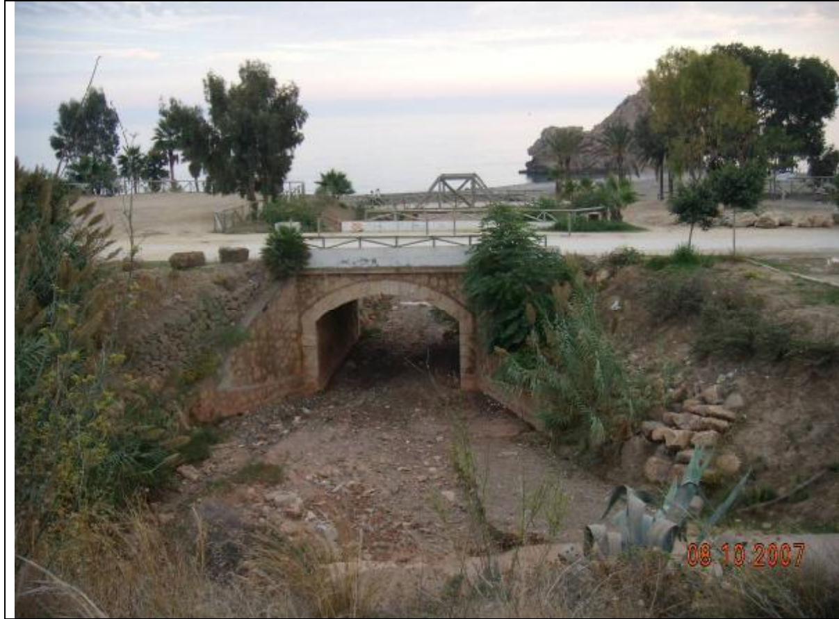
Fotografía 1 – Desde la autovía vemos la obra de paso bajo la antigua plataforma del ferrocarril
