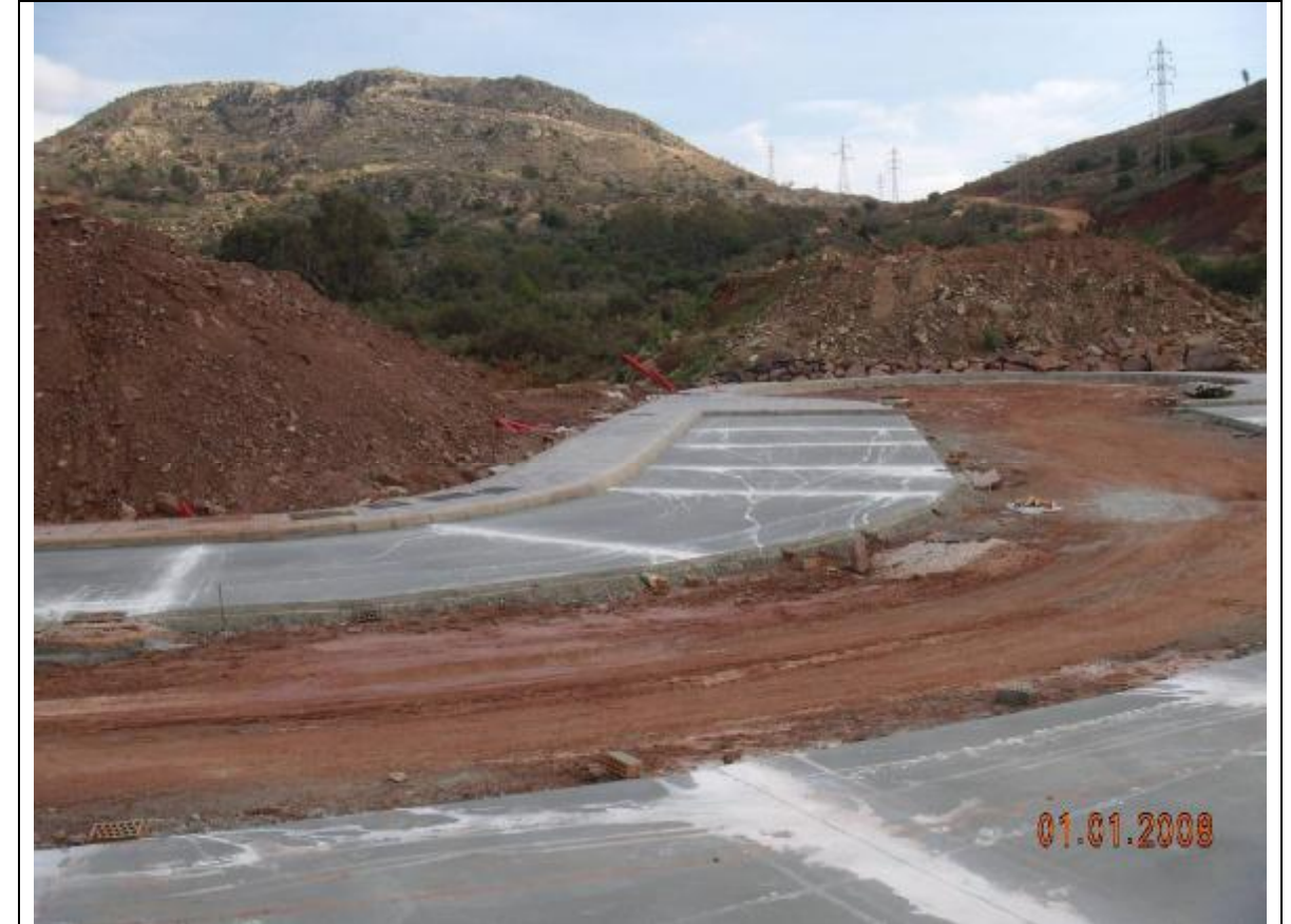
Fotografía 23 – Tras la calle en construcción se encuentra la boquilla de la fotografía nº 20. Vemos al fondo la vaguada que genera el arroyo más oriental.
