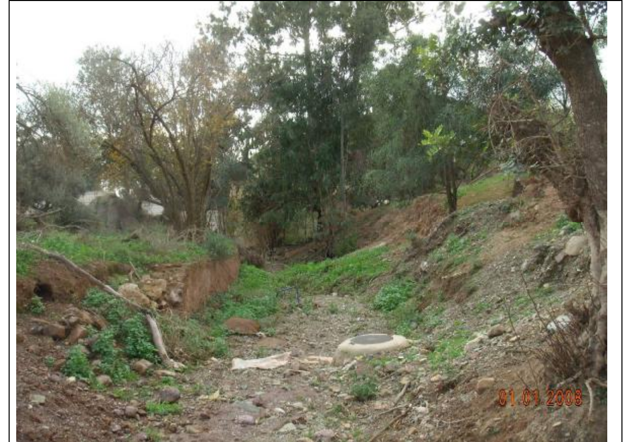
Fotografía 19 – Vemos como se dirige el cauce hacia aguas abajo. La próxima obra será el cajón que mostramos en la fotografía nº 8.
